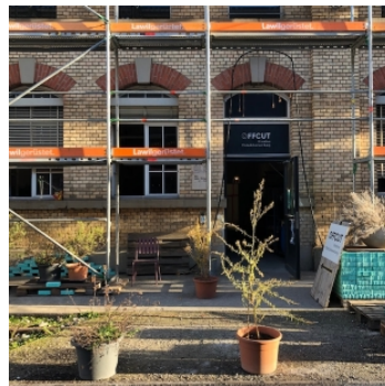
Gerüst vor dem Gebäude
